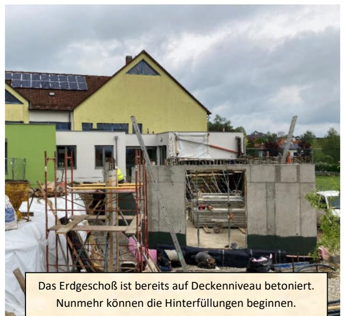
Das Erdgeschoß ist bereits auf Deckenniveau betoniert. Nunmehr können die Hinterfüllungen beginnen.
